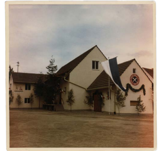
Im Hauptteil der Anlage stand den Mitgliedern eine Saatgutreinigungsmaschine zur Verfügung. Außerdem wurden dort Kohlen, Kunstdünger und Futtermittel gelagert. Im Anbau rechts befand sich die hydraulische Obstpresse.
