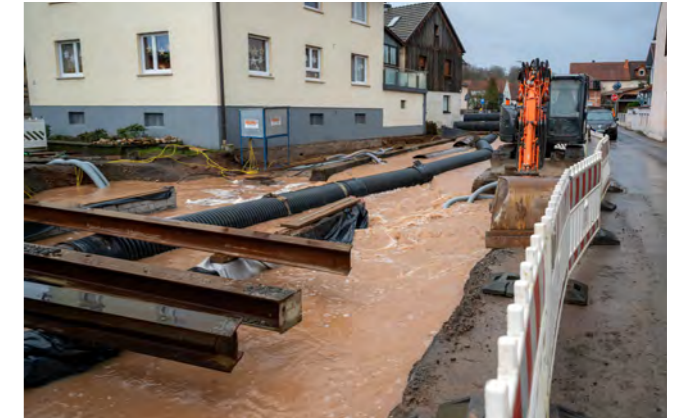
Die Baustelle im Ort behinderte das Wasser zusätzlich.
